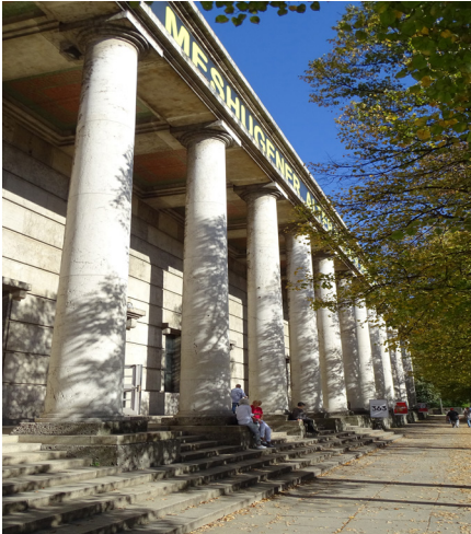
...errichtet im Dritten Reich
