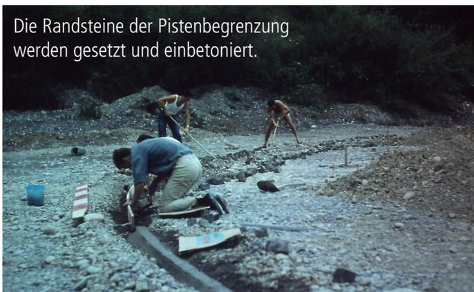
Die Segmente werden mit Latten abgesteckt, dann in Beton gegossen...
